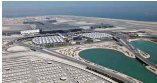
Hamad International Airport 哈马德国际机场 (卡塔尔)
